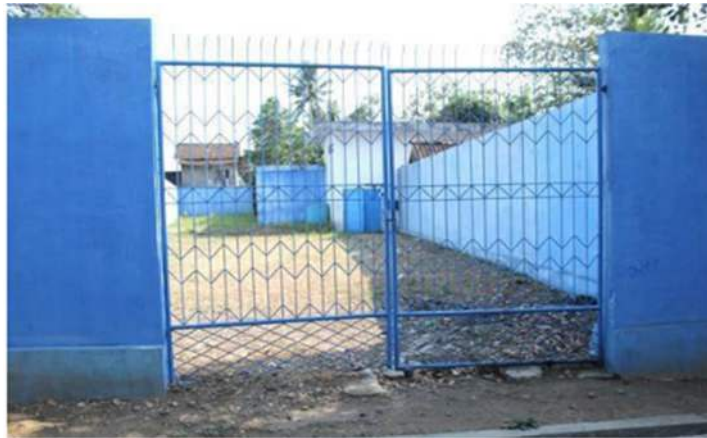
Gambar 2.5 Reservoir Gumukrejo Kapasitas 800 M 3
